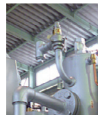
SD120のボイラー設置状況
